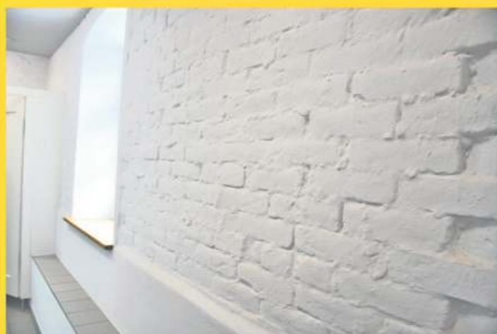
Geschlämmtes altes Mauerwerk
