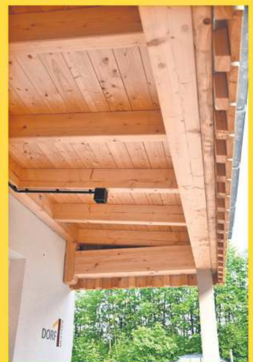
Neue Überdachung im Eingangsbereich mit Logo
