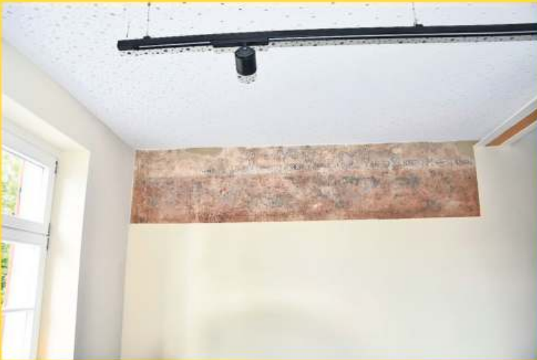
Erdgeschoss: Stück alte Wandfarbe in der Stube
