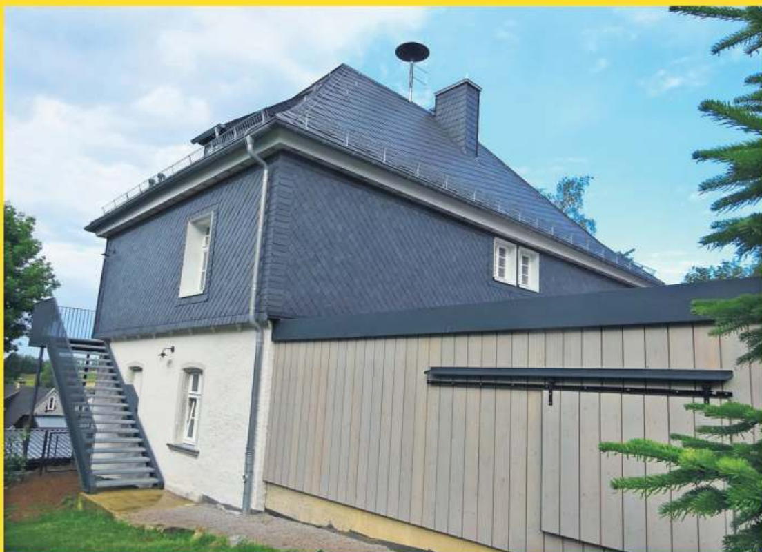
Ansicht von Osten mit Brandschutzterre
