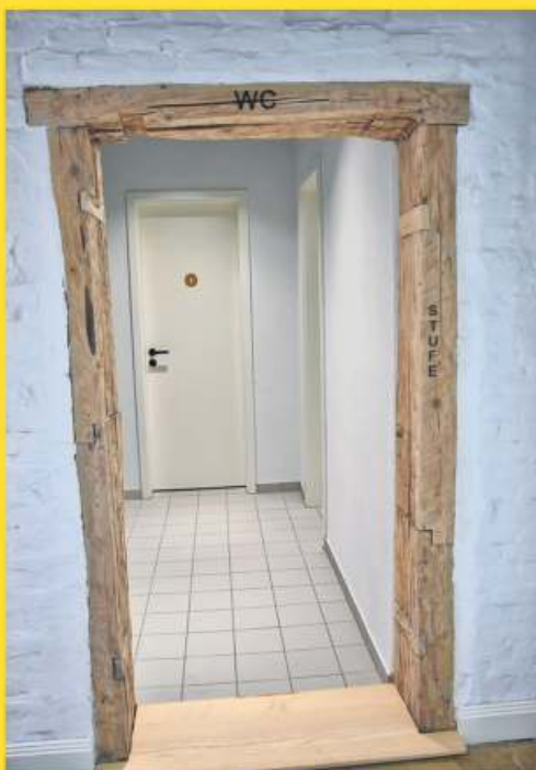
Historische Türrahmen im Erdgeschoss freigelegt
